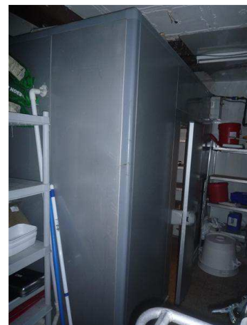
Chambre froide MATRIX 3 x 1,50 m env. Groupe froid séparé
